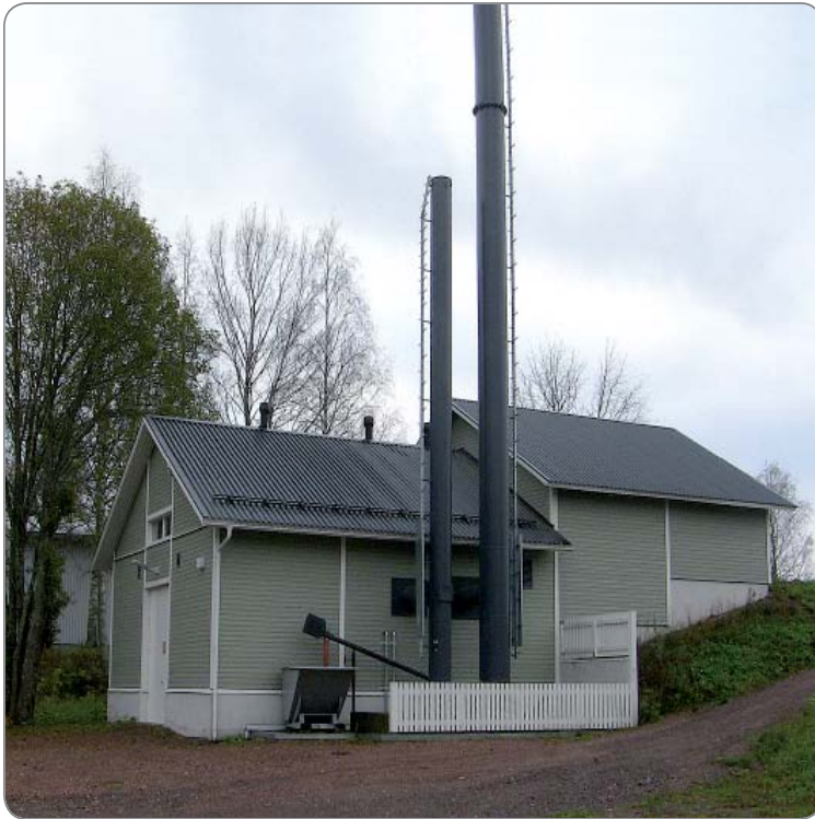
Kuva 1. Pusulan aluelämpölaitos. Kuva: Kari Vuorio
