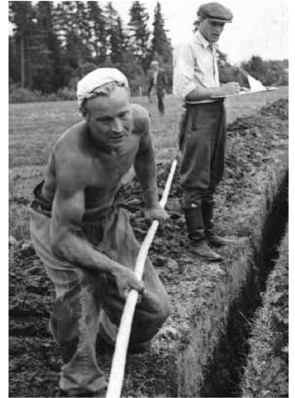
Salaojankaivuun työnmenekkiä selvitetään vuonna 1946.
