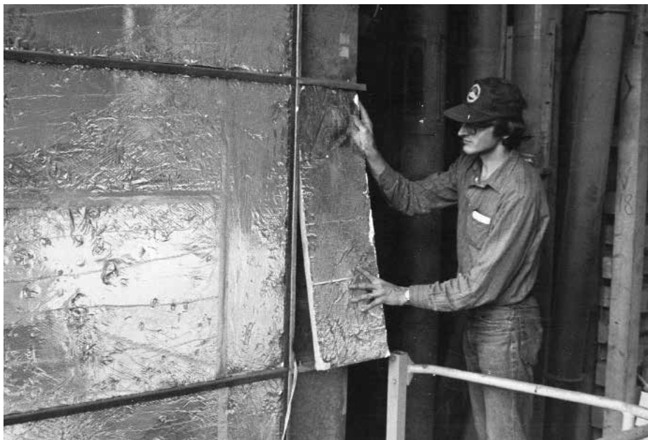
Tutkimusten mukaan viljankuivurin eristäminen paransi viljankuivauksen tehokkuutta yli 15 prosenttia.
