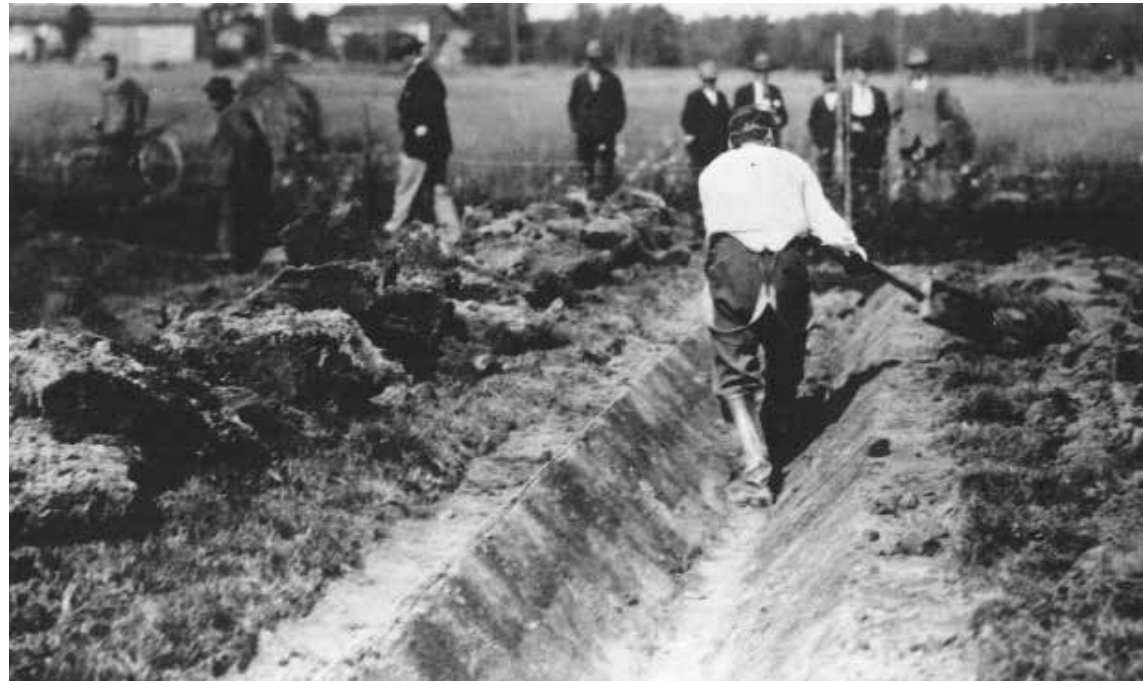
Ojankaivuukilpailuissa haettiin pitäjän ja lopuksi valtakunnan työmestaria.
