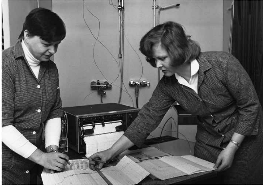
Kotitalouskoneiden testauksissa tehtiin tarkkoja mittauksia veden ja sähkön kulutuksista.
