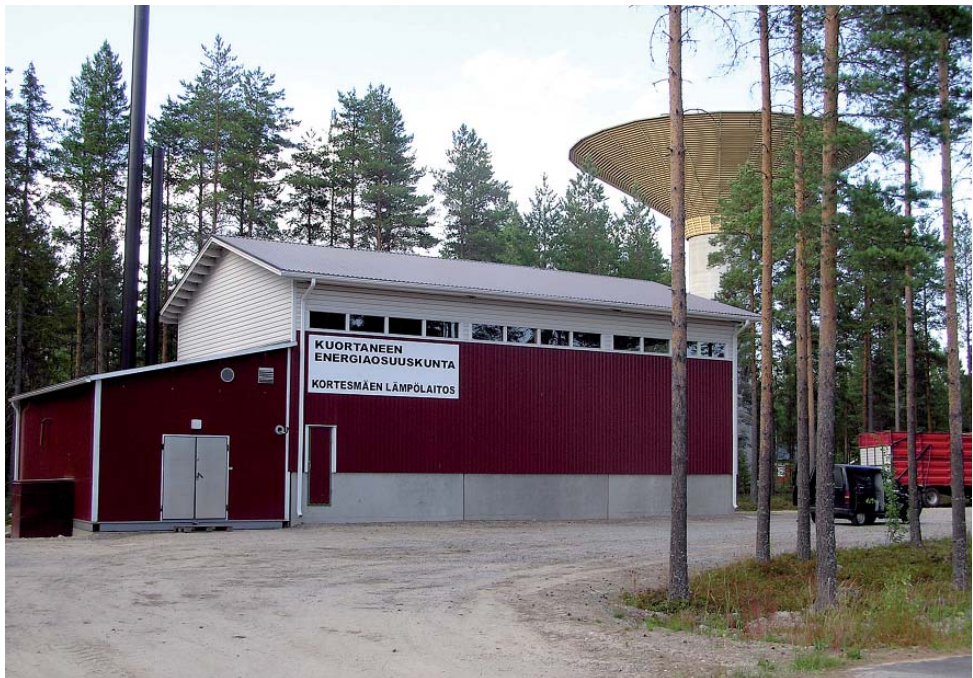
Kuva 3. Korttesmäen yhden megawatin laitos käynnistyi 2005 ja sillä lämmitetään lähialueen rivi- ja omakotitaloja ja liikekiinteistöjä. Kuva: Asko Sippola
